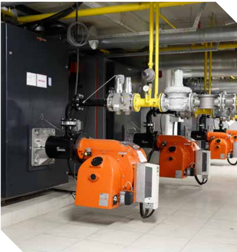
300.000 m 2 inşaat alanına sahip 900 yatak kapasiteli Ordu Şehir Hastanesinin mekanik işleri. (Ordu / 2026) ◀
