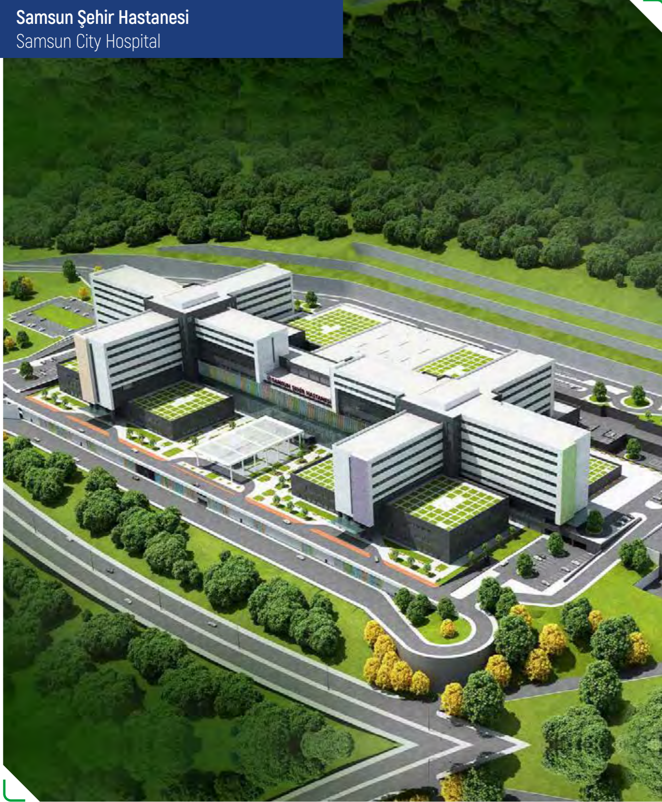
► 300.000 m 2 inŐaat alanına sahip 900 yatak kapasiteli Samsun Őehir Hastanesinin Galeriler Hatları, kazan dairesi ve TSB binaları, tm mhendislik iŐleri ve mekanik saha alıŐmalarının yapılması.
